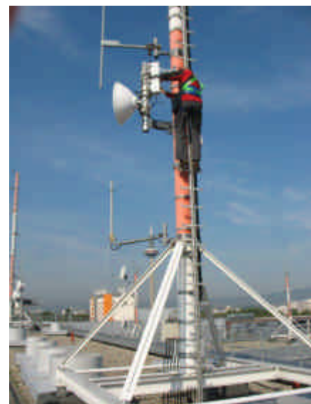
CBL-Techniker bei der Ausrichtung der Antenne
