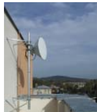
Montagevariante der 60 cm- Parabolantenne
