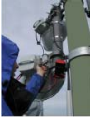
Ausrichten der Antennen an der Relaisstation
