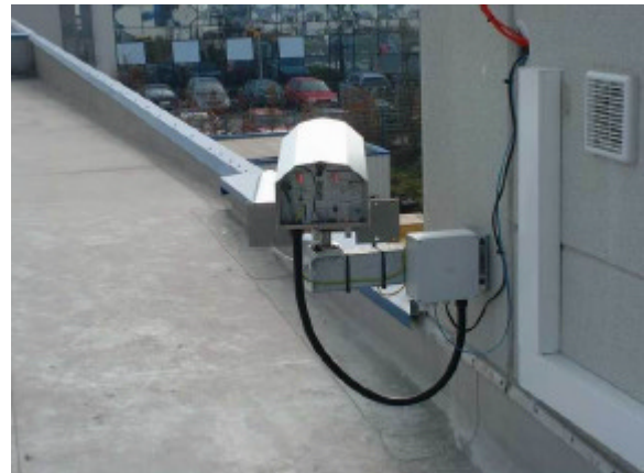
Beispiel für eine Montage auf einem Wandhalter Z9040
