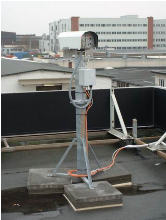
Beispiel für eine Montage auf einem Standgestell Z9015
