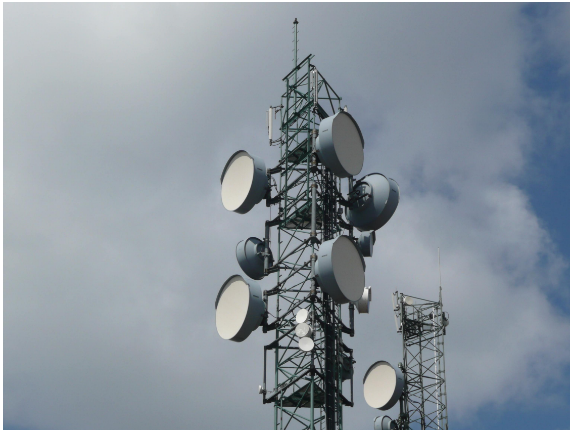
Beispiel Antennenmontage an Masten
